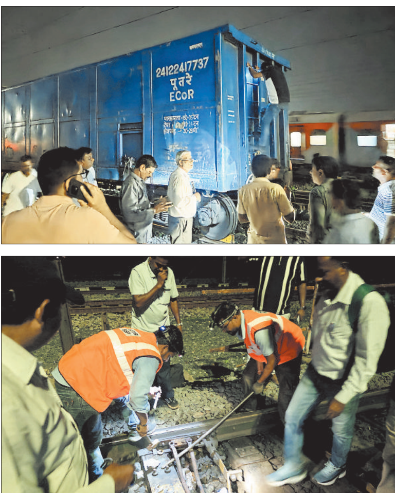
चुचुहियापारा रेलवे अंडरब्रिज पर मालगाड़ी का वैगन पटरी से उतरा, लाइन में सुधार करते रेलवे कर्मचारी।
